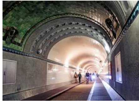
Der alte Elbtunnel verläuft 24 Meter unter der Oberfläche FOTO: A. LAIBLE
